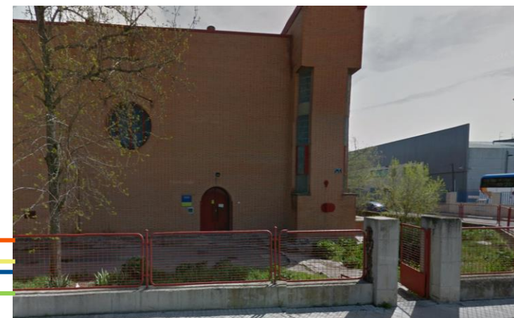
Central de conmutación (OBA)
