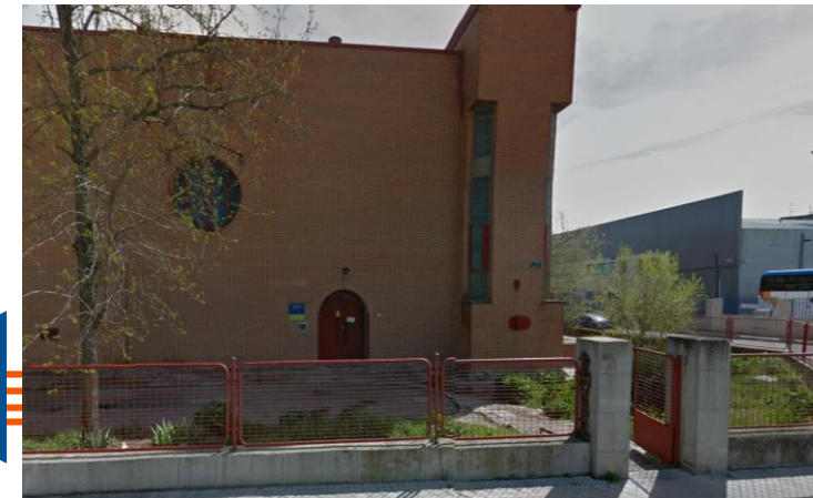
Central de conmutación (OBA)
