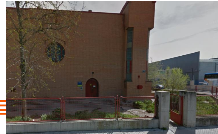
Central de conmutación (OBA)
